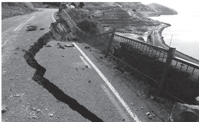
Последствия разрушений после землетрясения на Аляске 23 января 2018 г.
