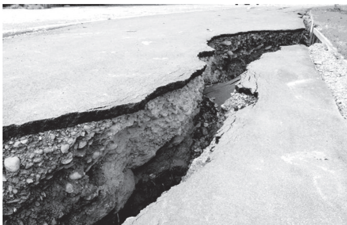
Разрыв поверхности Земли в результате землетрясения в Гондурасе, 10 января 2018 г.
