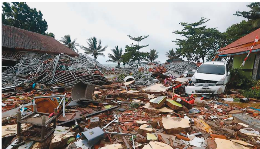
Последствия землетрясения на острове Сулавеси 12 апреля 2019 г. с магнитудой M = 6,6
