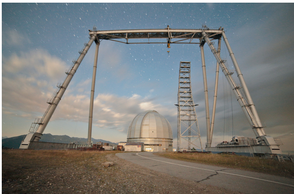
БТА вечером. Два крана необходимы при замене и обслуживании крупногабаритных деталей
