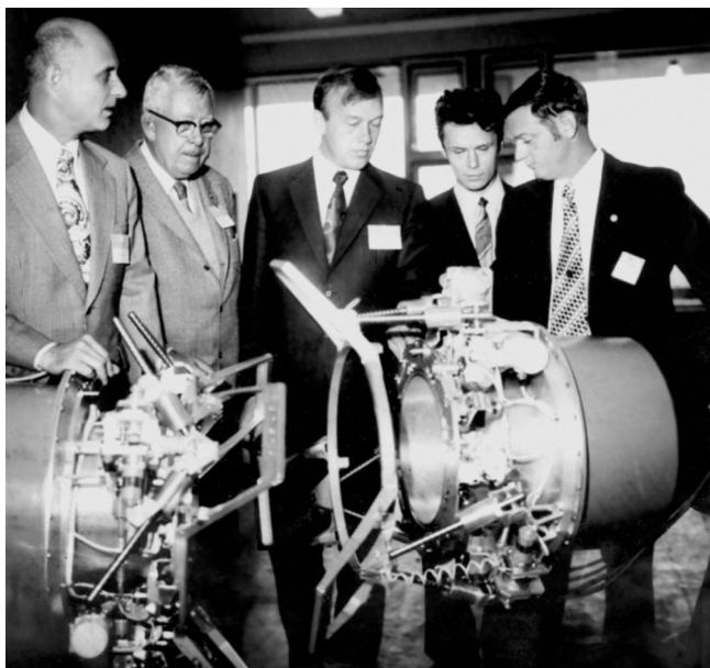
Томас Стаффорд, представитель NASA, А.С. Елисеев, В.С. Сыромятников, Гленн Ланни (NASA) осматривают универсальную (андрогинную) стыковочную систему перед ее тестированием. Институт космических исследований АН СССР, октябрь 1972 г. Фотоархив ЦНИИмаш
