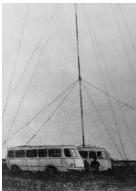
Прецизионная наземная установка для измерения поглощения радиоволн, созданная в ГДР, вблизи старта ракеты на космодроме Капустин Яр. Фото из ст. Грингауз К. И., Серафимов К. Б., Шмеловский К. Г., Шмилауэр К. Ионосферные исследования, выполненные на спутниках и ракетах, запущенных по программе «Интеркосмос». По программе «Интеркосмос» под ред. д.ф.-м.н. Г. С. Нариманова. М., Машиностроение, 1976. С. 25
