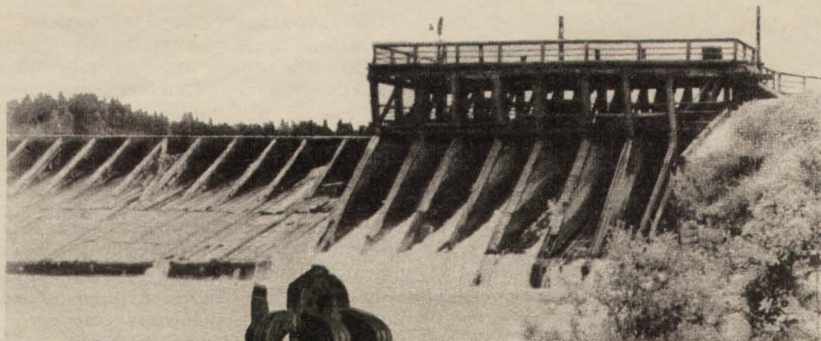
Плотина одного из металлургических заводов. Построена в начале XIX века.
