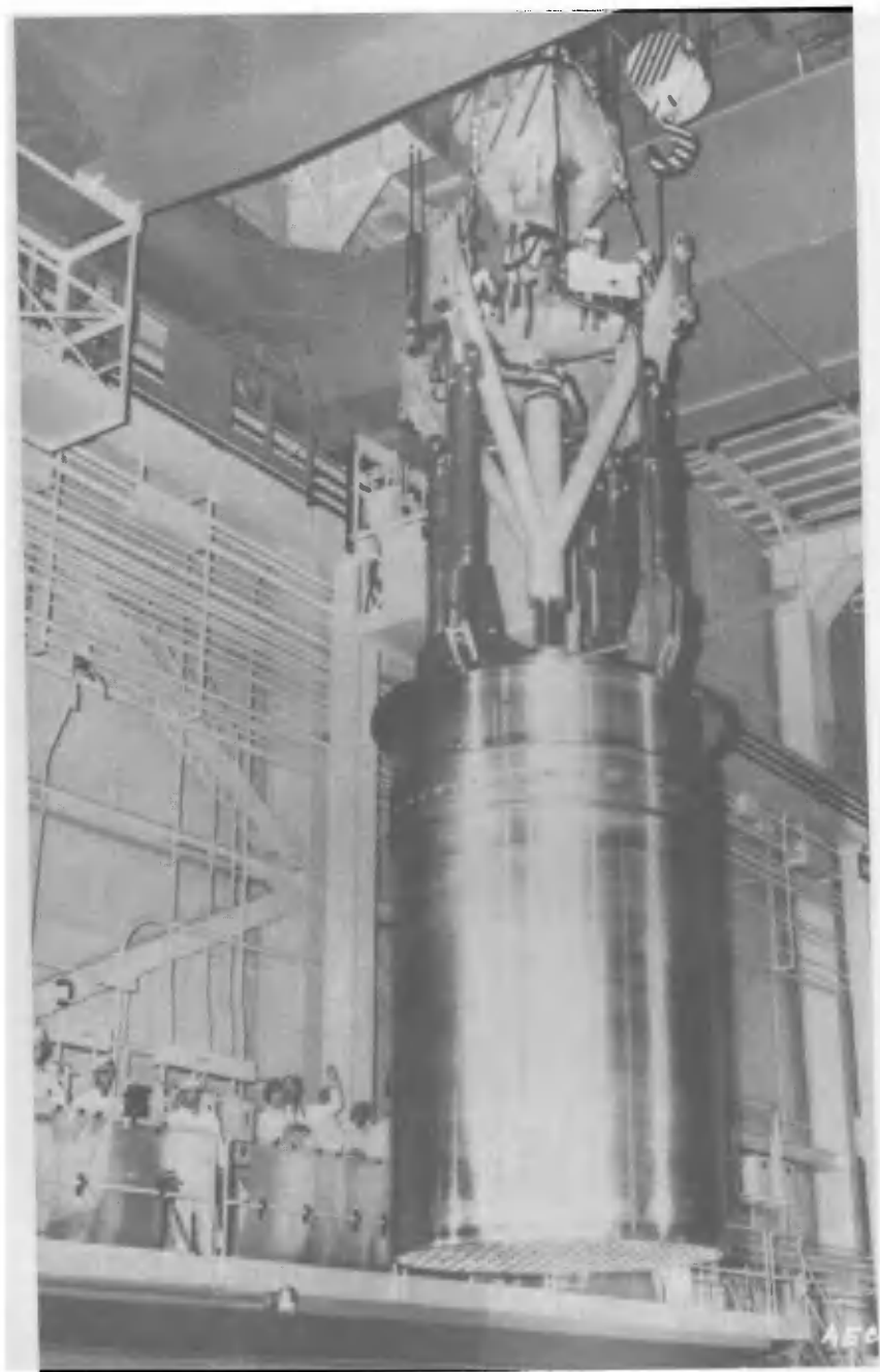
Центральная часть ядерного реактора одной из атомных электростанций, расположенной в Шиппингпорте (штат Пенсильвания)
