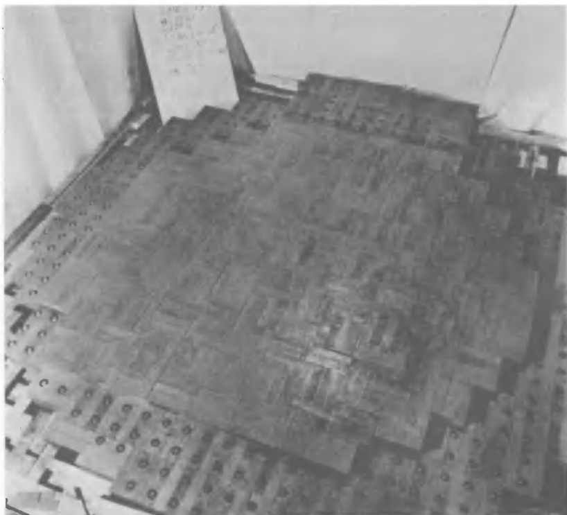
Строительство чикагского реактора. Единственная фотография, сделанная в то время. Стержни в отверстиях — цилиндрические урановые сборки. Показан момент укладки 19-го слоя графитовых блоков (замедлителя)
