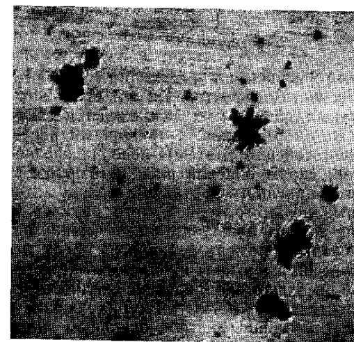
Рис. 3.19. Очаги межкристаллитной коррозии на стальной лопатке ротора компрессора (10-кратное увеличение)
