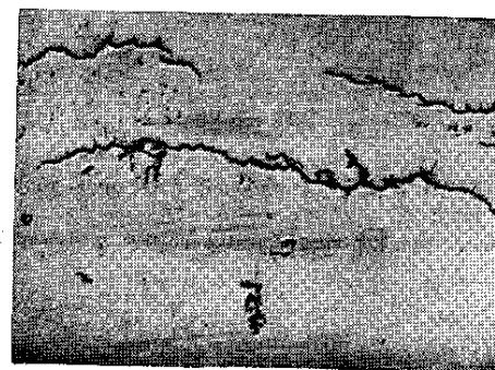
Рис. 3.13. Трещины коррозии под напряжением на поверхности реборды авиационного колеса
