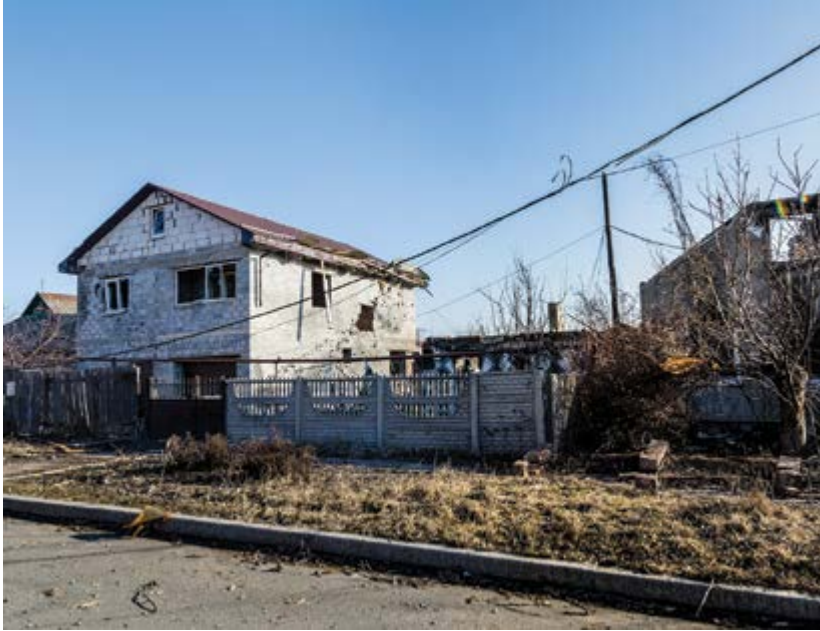
Разрушенные жилые дома в непосредственной близости от донецкого аэропорта.
