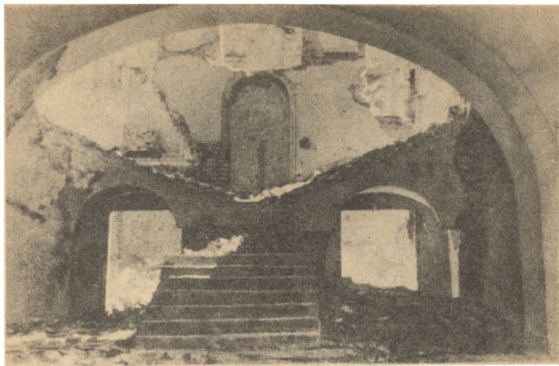
Развалины здания Инженерного управления.
