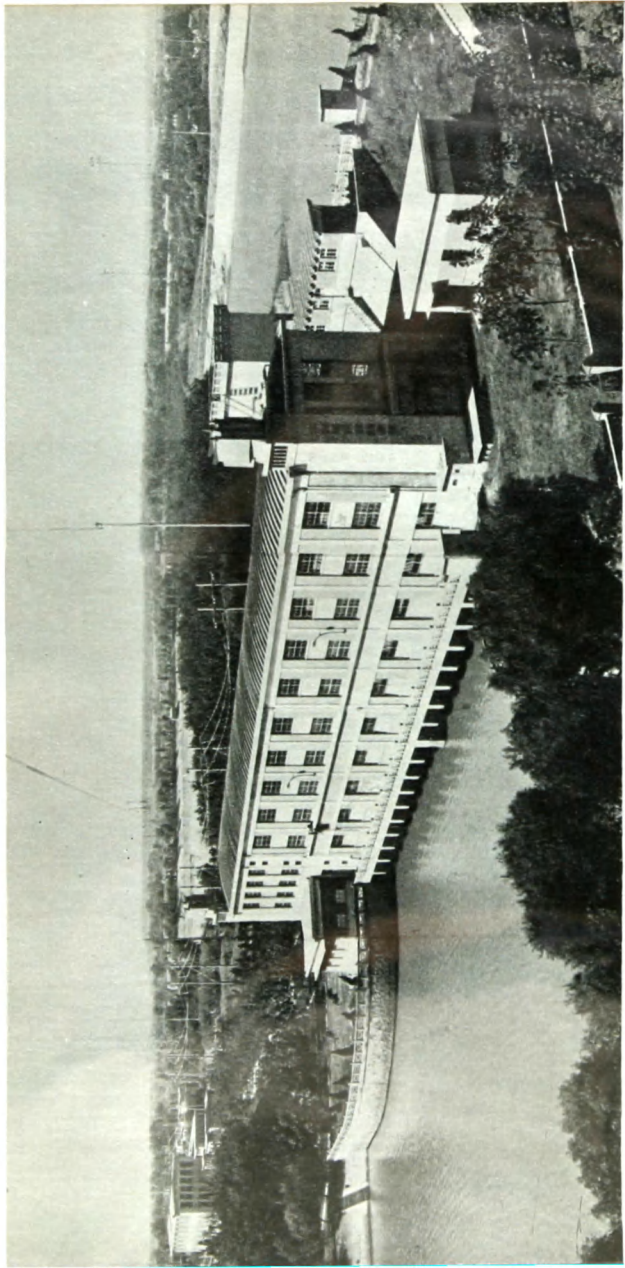
Цзяндуская насосная станция в провинции Цзянсу. Этот крупный гидроузел подает 460 кубических метров воды в секунду, орошая больше 200 тысяч с лишним гектаров угодий в районе Лисяхэ.
