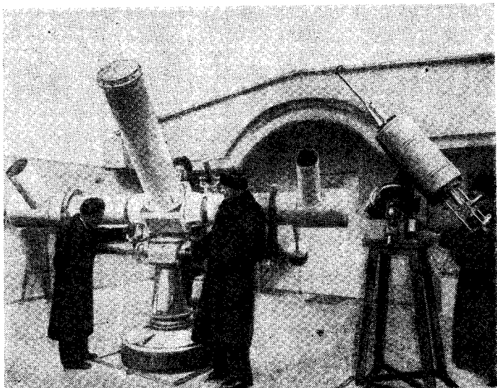
Рис. 31. Большой пулковский звездный интерферометр системы В. П. Линника
