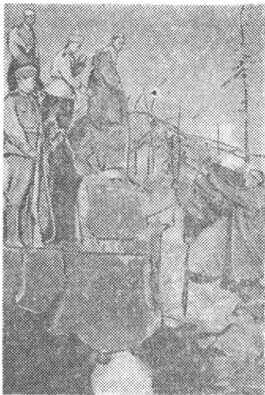
Японский дот взорван. Толщина его перекрытия оказалась 1,5 метра.
