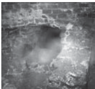
Фото 2. Арка, присыпанная землей, — вход в тоннель. Камера зафиксировала идущие из него испарения
