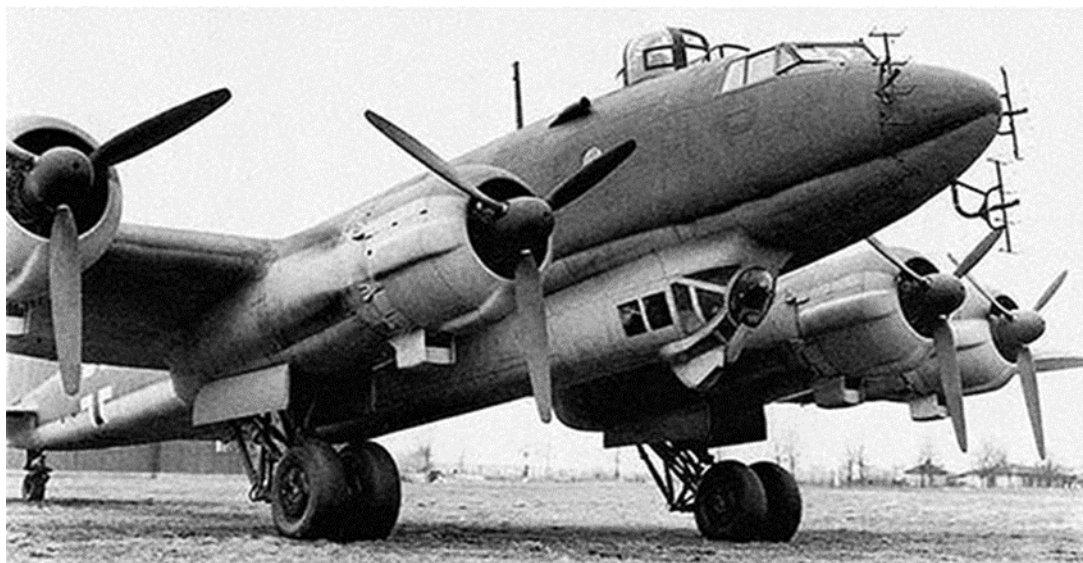
«Кондор» модификации С-6 с радиолокатором, 1943 год
