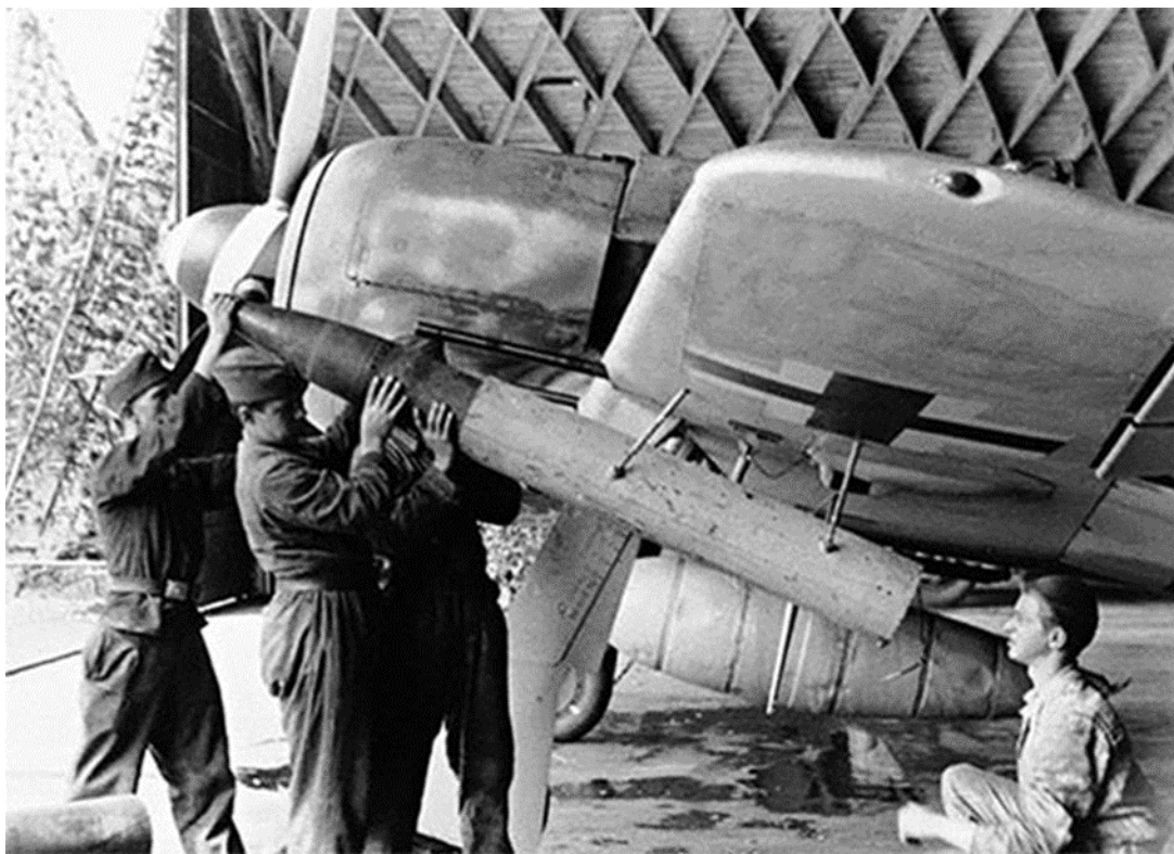
Закладка ракеты BR21 в пусковое устройство истребителя Fw-190
