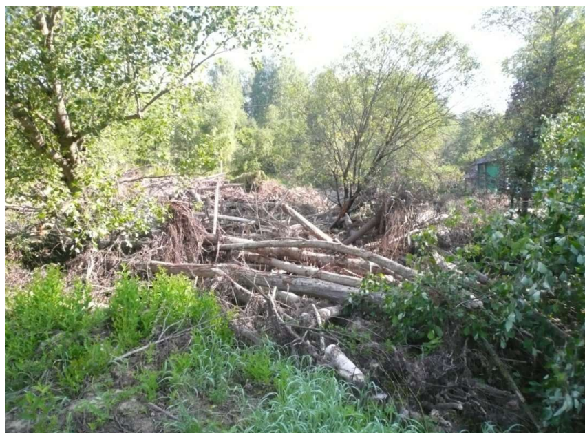
Рисунок 2. Карчи, скопившиеся перед мостовым отверстием дороги Яжелбицы-Дворец.
