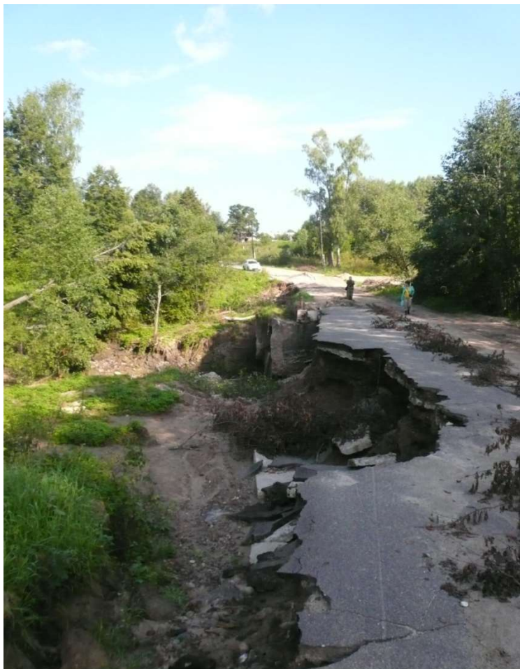
Рисунок 3. Размыв автодороги и частичное разрушение мостового перехода. Фото А.Ю. Виноградова Figure 3. Road erosion and partial destruction of the bridge crossing. Photo by Alexey Yu. Vinogradov
