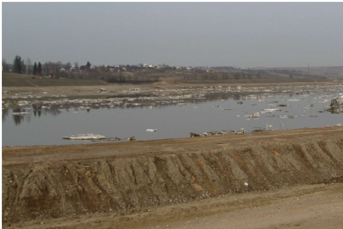
Рисунок 3. Эрозионные рытвины на незадернованной неуплотненной дамбе. Фото А.В. Шалаева
