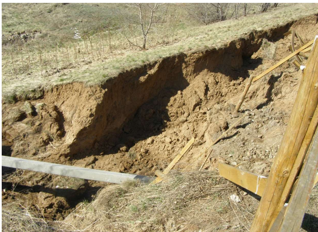
Рисунок 2. Размыв низового откоса грунтовой плотины р. Кокпекты. Фото А.Ю. Виноградова
