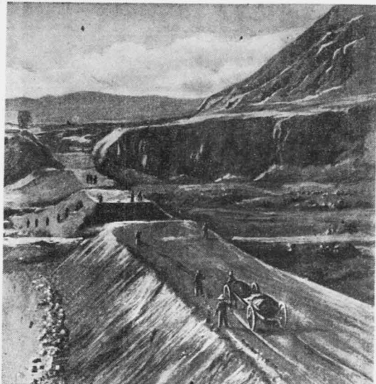
Для укрепления обороноспособности своей страны героический китайский народ строит новую сеть усовершенствованных дорог. На снимке: шоссевое строительство в провинции Юньнань.
