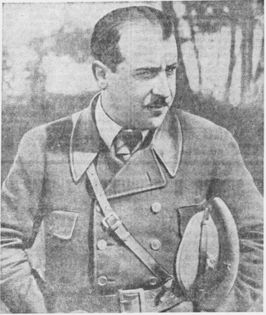
Матз Залка (генерал Лунач) в Испании.
