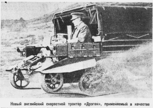
Новый английский скоростной трактор «Драгон», примененный в качестве тягача легких пехотных пушек.
