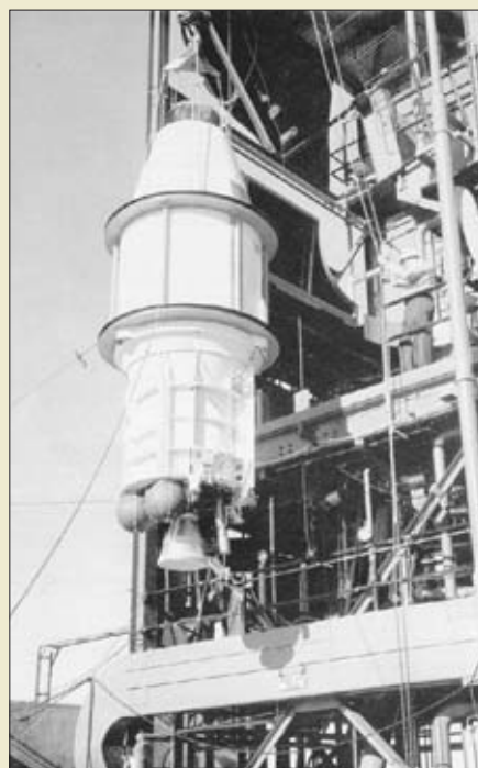
Ступень Агены-А, применявшаяся для запуска первых спутников CORONA
