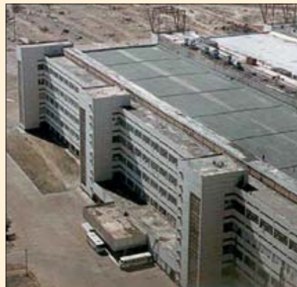
Сооружение 92А-50 на космодроме Байконур
