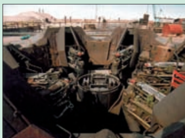
Стартовое устройство РН «Протон» на новой ПУ и башня обслуживания
