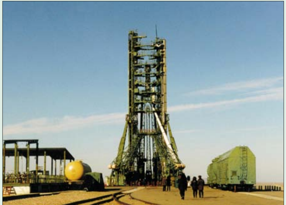
31-я площадка до реконструкции. Скоро отсюда будут стартовать «Союзы» с РБ «Фрегат»
