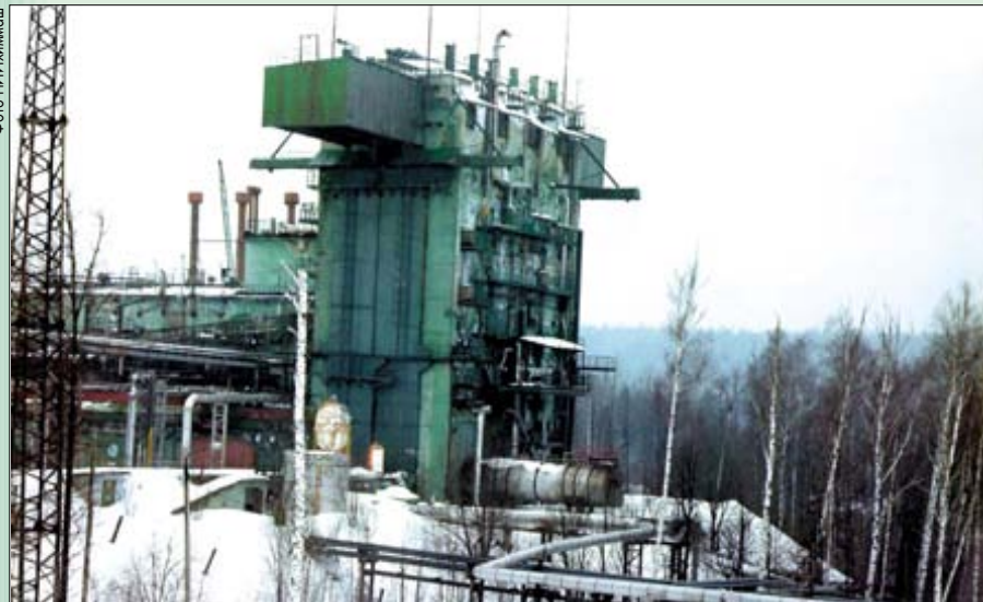
Стенд В3, на котором отработывается кислородно-водородный разгонный блок 12КРБ
