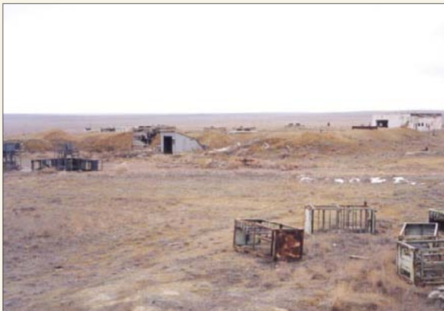
Подземный командный пункт на площадке 161
