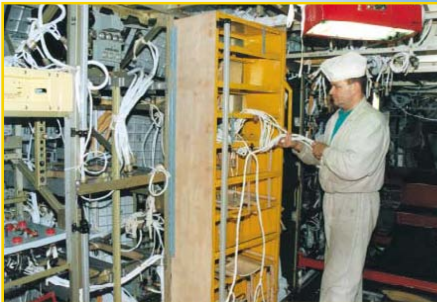
Монтаж бортовой кабельной сети на СМ. Январь 1998 г.
