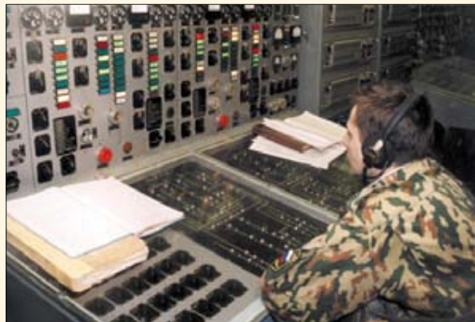
Пульт управления заправкой РН «Космос-3М» компонентами топлива
