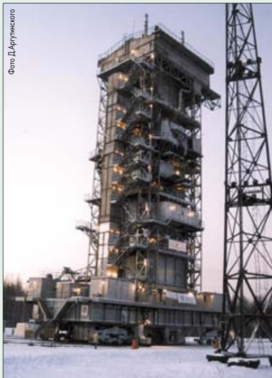
Мобильный АО, скрывающий в своих недрах носитель «Космос-3М» с КА QuickBird-1
