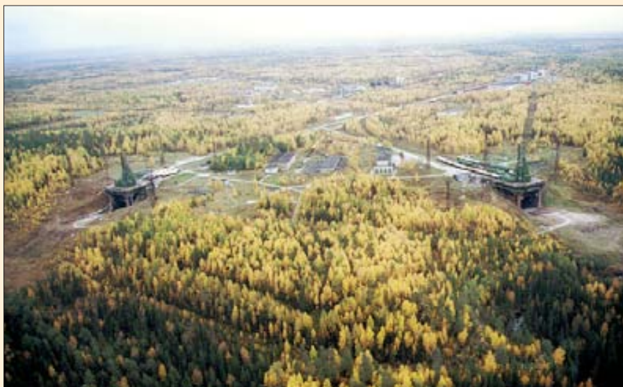
Вид с вертолета на 43-ю площадку
