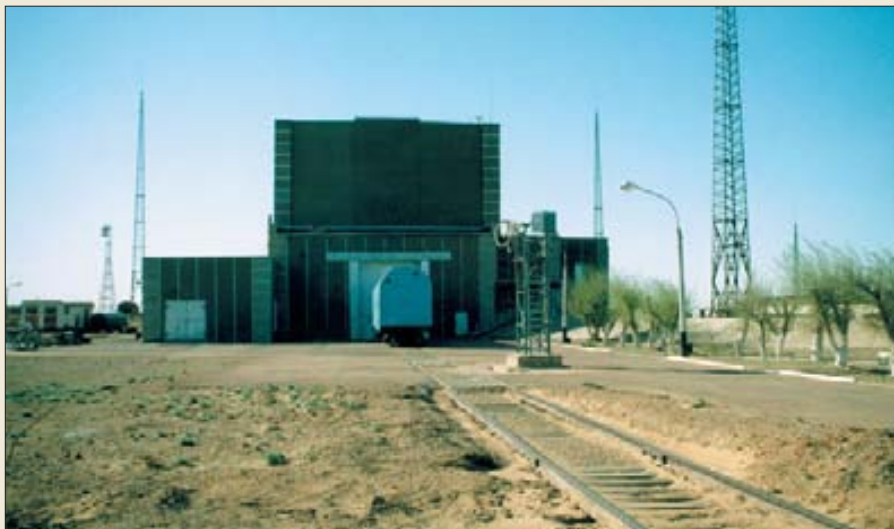
Заправочная станция 11Г12 на площадке 32 космодрома Байконур
