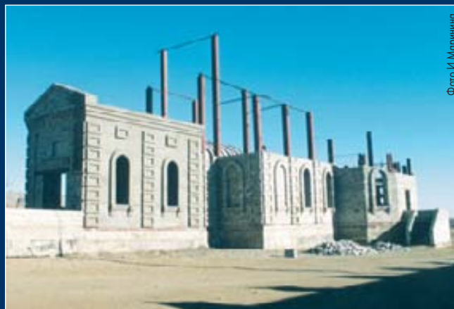
Строительство православной церкви в городе
