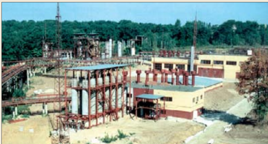
Строительство комплекса по производству жидкого водорода
