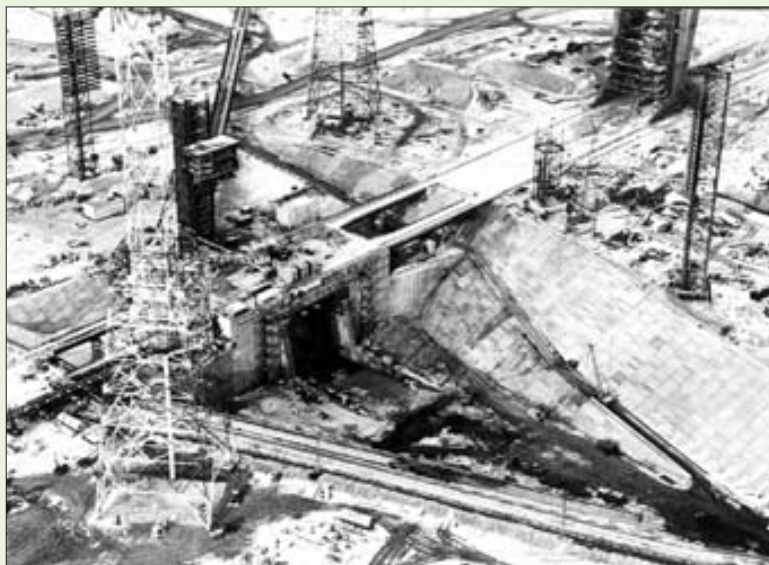
Вид на УКСС со стороны газоваода
