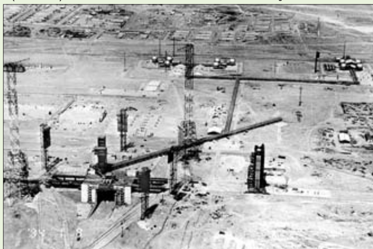
Площадка УКСС с высоты птичьего полета
