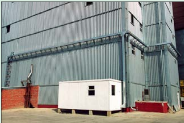
По внешним плоскостям МИКа 92А-50 проложены антенно-фидерные тракты
