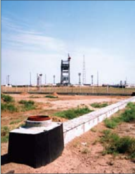
Лотковая канализация для прокладки оптоволоконна
