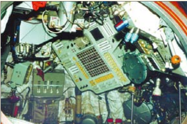
Вид на пульт управления ВА через входной люк
