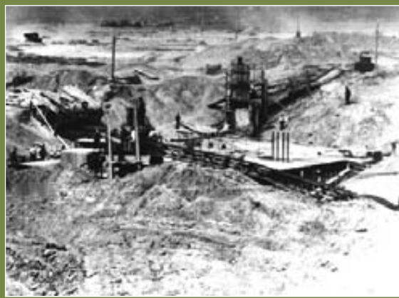
Строительство первого старта
