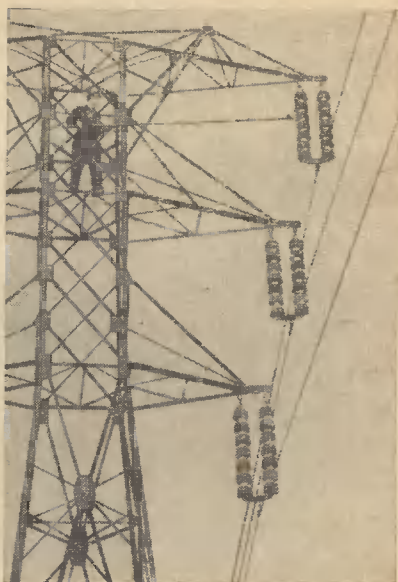
Рис. 9. Контроль подвесных изоляторов измерительной штангой.
