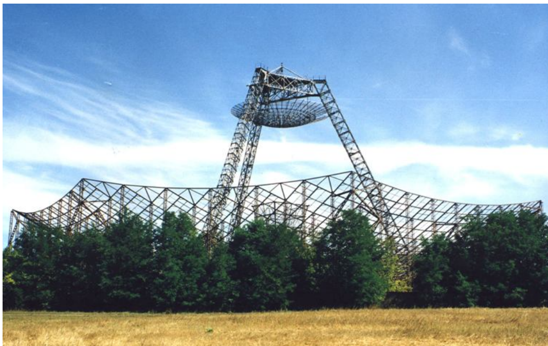
Зенитная параболическая антенна диаметром 100 м (Харьковский радар)
