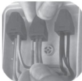
специальной контактной пастой, которая при подключении алюминиевого проводника автоматически снимает с него окисную пленку и смазывает его для защиты от повторного окисления. Алюминиевые проводники с признаками явного сильного окисления (определяется визуально по темной окраске) следует перед подсоединением очищать механически.
