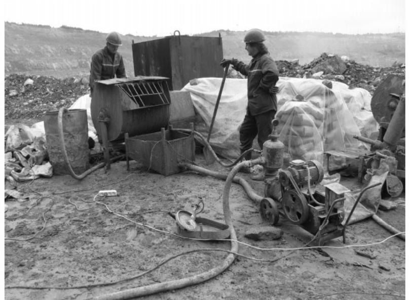
**Рис.3. Инъекционное оборудование на участке опытного закрепления скального уступа борта карьера**
