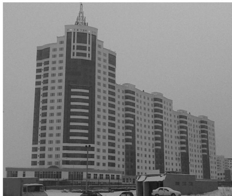
**Рис.2. 22-этажное здание в г.Старый Оскол на закрепленных грунтах основания**
