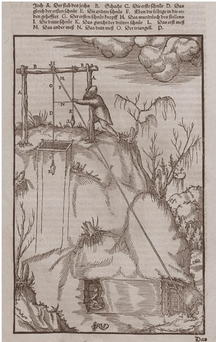
Рис. 1. Иллюстрация из книги Г. Агриколы с задачей вентиляционной сбойки
