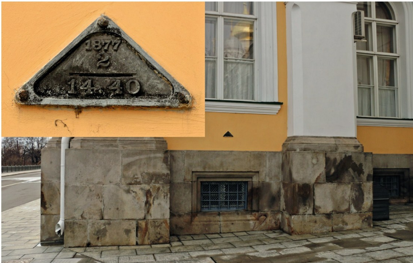
Рис. 6. Нивелирная марка, установленная в стене Николаевского императорского дворца (в настоящее время – Большой Кремлевский дворец). Фото автора, март 2019 года
