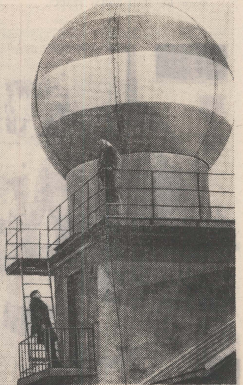
Метеорологический радиолокатор, который вы видите на снимке, установлен недавно на аэрометостанции в Липеае — одной из старейших в стране.
