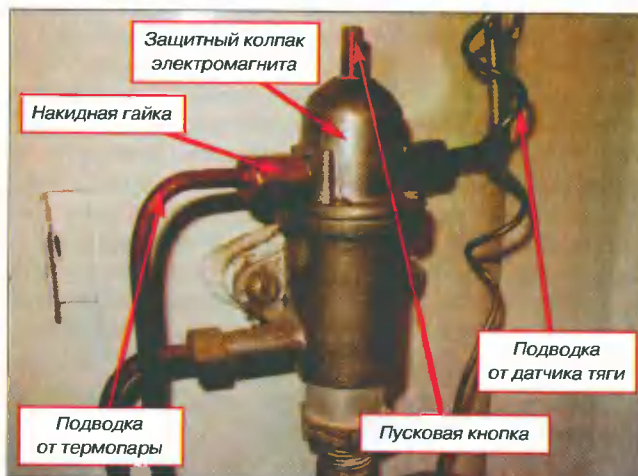
Рис. 7. Расположение элементов автоматики газового котла
