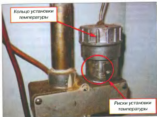
Рис. 4. Регулятор температуры
