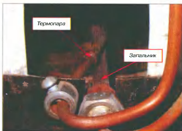
Рис. 10. Расположение термопары и запальника
