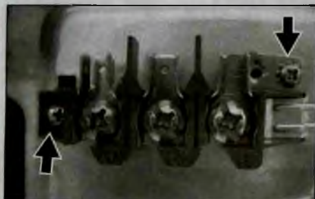
Рис. 17. Замена клеммной колодки
