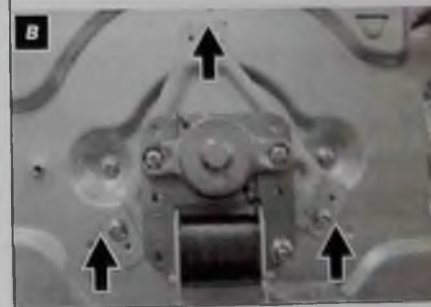
Рис. 8. Замена электромоторов вентиляторов конвекции
