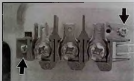
Рис. 12. Замена клеммной колодки
