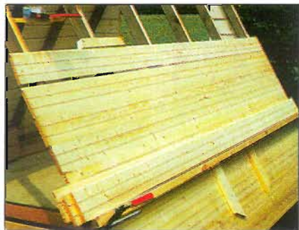
8. Обшивку по стропилам ведут снизу вверх.
