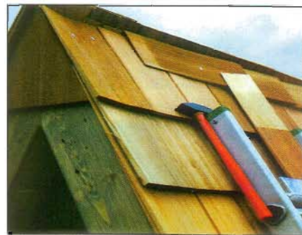
13. На стороне, откуда чаще всего дуют ветры, гонт выступает над коньком на 40 мм. С другой стороны крыши, вплотную к выступающим над коньком досочкам, примыкают досочки, укладываемые поперек. И в этом случае досочки крепят одним гвоздем (чтобы они могли «дышать»).
