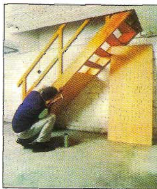
Обшивают фанерой нижнюю часть лестницы.
