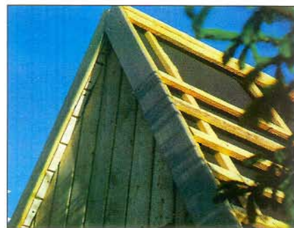
11. Рубероид с напуском 100 мм крепят гвоздями с широкой головкой. Он должен иметь соответствующий запас, чтобы его можно было загнуть и закрепить на свесах крыши. К вспомогательным стропилам прибивают бруски горизонтальной обрешетки (расстояние между брусками 150 мм).
