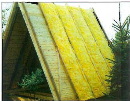
10. Утеплитель укладывается между вспомогательными стропилами.
