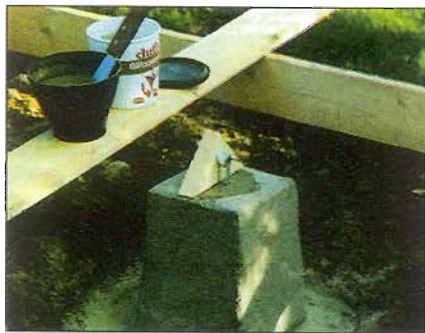
2. Одинаковые деревянные треугольники удерживают анкеры в нужном положении, пока их не «схватит» цементный раствор.
