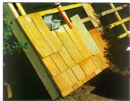
12. Первый ряд (нижний) гонтовых досочек укладывают в два слоя, а все остальные — в один со смещением стыков и с перекрытием предшествующего ряда последующим на половину длины досочек. Расстояние между досочками в ряду — 10 мм. Каждую досочку прибивают одним гвоздем, забиваемым в середине досочки.
