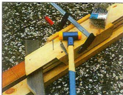
3. Затяжки (они же балки для пола) состоят из четырех досок. Проемы для стропил сначала заполняют короткими досками.
