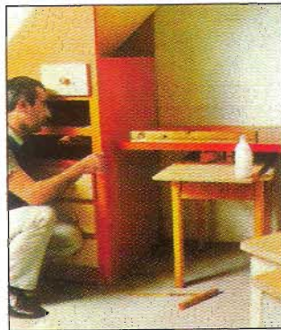
Плита рабочего стола привинчивается справа к полке стеллажа, слева — к боковой стенке шкафа.
