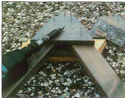
5. В коньке две стропильные ноги соединяют с помощью накладок. Сборку стропильной фермы производят на ровной площадке.
