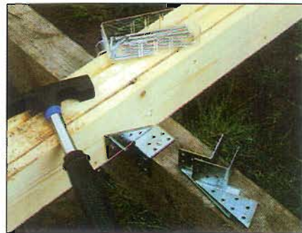
7. После выверки стропильных ферм их крепят к опорным балкам сначала несколькими гвоздями, а затем соединительными пластинками.
