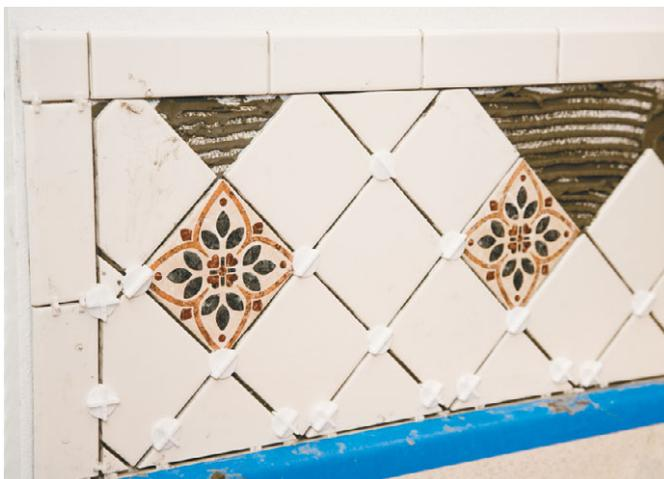
Наиболее сложным из классических способов укладки плитки является «диагональ». Для него подходит только квадратная плитка (в противном случае вы получите неоправданно большое количество обрезков). По этой технологии первый ряд выкладывают из специально подготовленных плиток-треугольников гипотенузой вниз. Последний ряд вновь выкладывается из треугольников.
