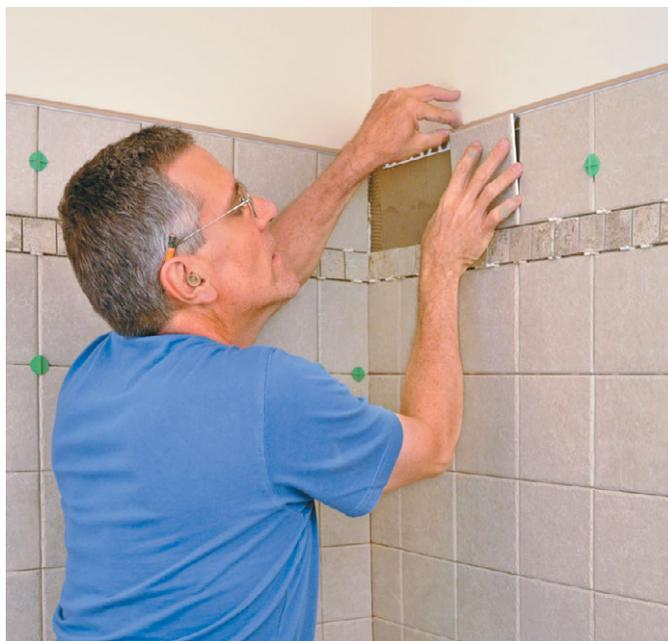
Наиболее распространенным способом укладки настенной плитки, заслужившим особую популярность в силу своей простоты и доступности, является «прямой ряд». В этом случае плитку
