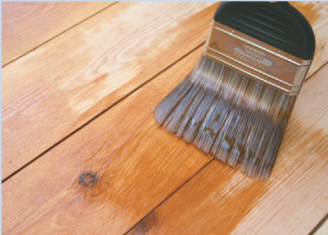
*Для защиты панелей вагонки от различных биологических воздействий рекомендуется сразу после окончания монтажа обработать облицованную поверхность антисептическим составом и в дальнейшем эту операцию периодически повторять.*
