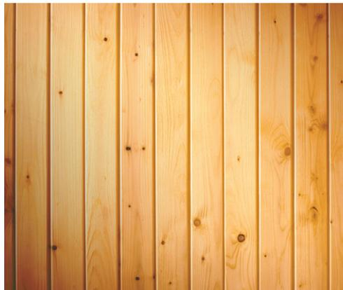
Существуют четыре основных варианта крепления вагонки: вертикальное, горизонтальное, диагональное и «елочкой». Наиболее часто используют горизонтальное крепление. В комнате с высоким или наклонным потолком оно может зрительно уменьшать высоту потолка, однако в комнате со средней высотой такой рисунок создает впечатление «придавленности», тяжести потолка. Диагональное крепление больше всего подходит к стилизованной современной обстановке.
