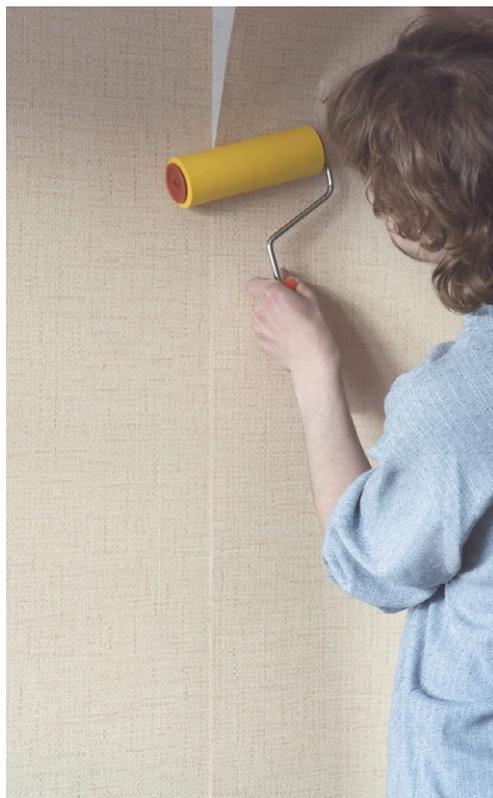
**Толстые обои обычно наклеиваются встык, иначе на стене будут выделяться места стыков, а тонкие, при желании, можно наклеивать и внахлест.**
