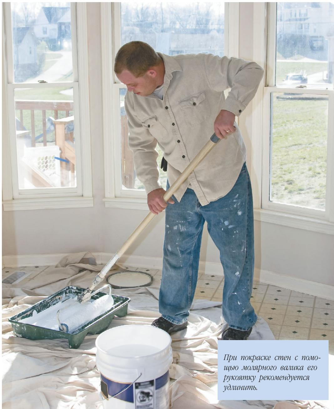
*При покраске стен с помощью молярного валика его рукоятку рекомендуется удлинить.*
