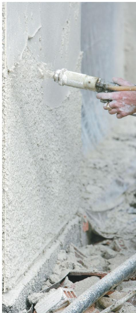
Штукатурные составы наносятся на подготовленное основание вручную. Возможно также применение пистолета для механического нанесения растворов.
