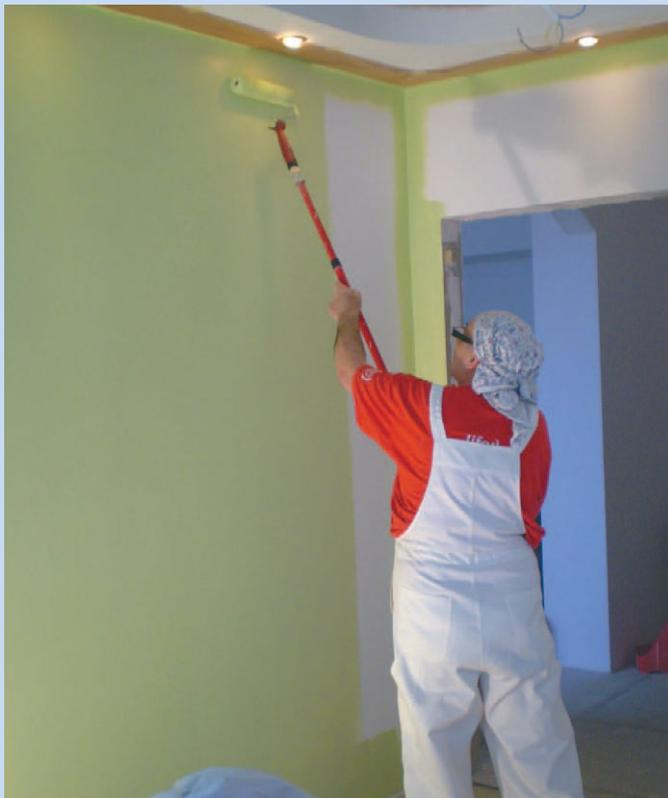
*На обрабатываемую поверхность водно-дисперсионные краски обычно наносят при помощи валика. Для получения качественного покрытия краска наносится в три слоя. Покраску первыми двумя слоями лучше всего производить меховым валиком с длинным ворсом, применяя большое количество краски. Благодаря этому окрашенная поверхность не высыхает слишком быстро, что дает возможность положить более ровный слой. Финишная покраска производится малярным валиком с ворсом средней длины.*
