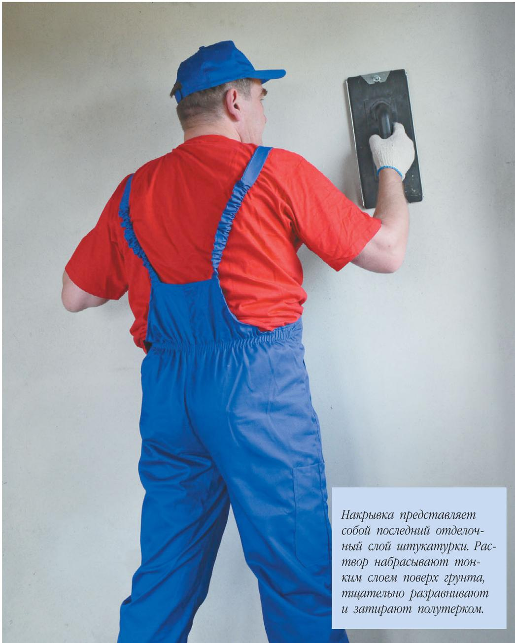
*Накрывка представляет собой последний отделочный слой штукатурки. Раствор набрасывают тонким слоем поверх грунта, тщательно разравнивают и затирают полутерком.*
