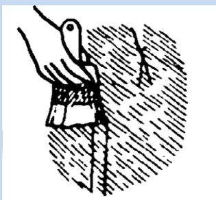
*Краску переносят на поверхность стены широкими и равномерными мазками.*
