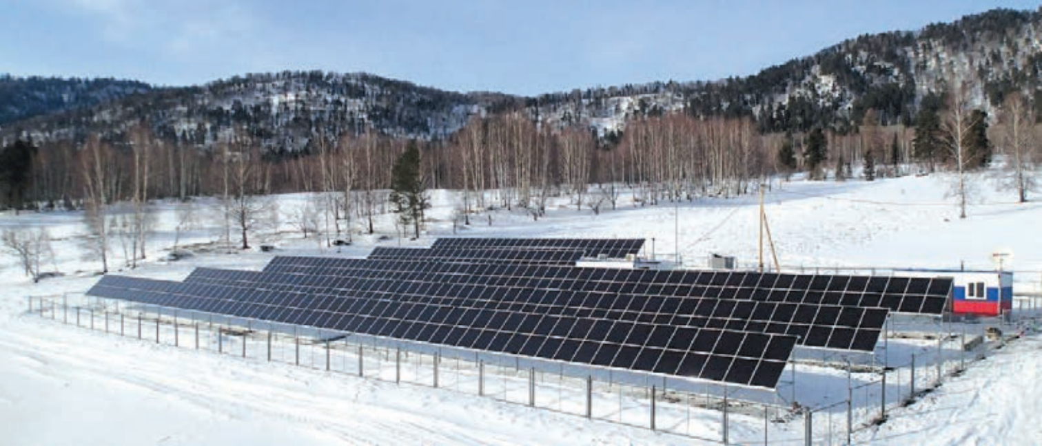
1. Гибридная дизель-солнечная энергоустановка в селе Яйлю, Республика Алтай. 2. Солнечные элементы на скатных крышах жилых домов. 3. Тонкопленочный солнечный модуль на основе аморфного кремния.
