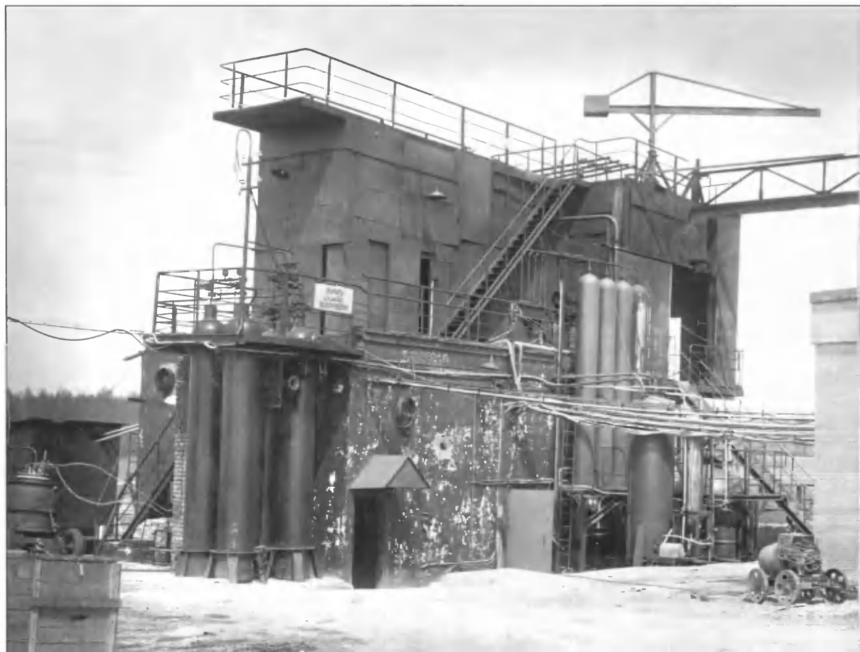
Стенд № 2 для огневых испытаний (1956 г.)
