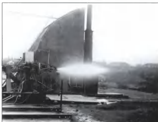
Огневые испытания двигателя РД-1ХЗ в Химках (1947 г.)
