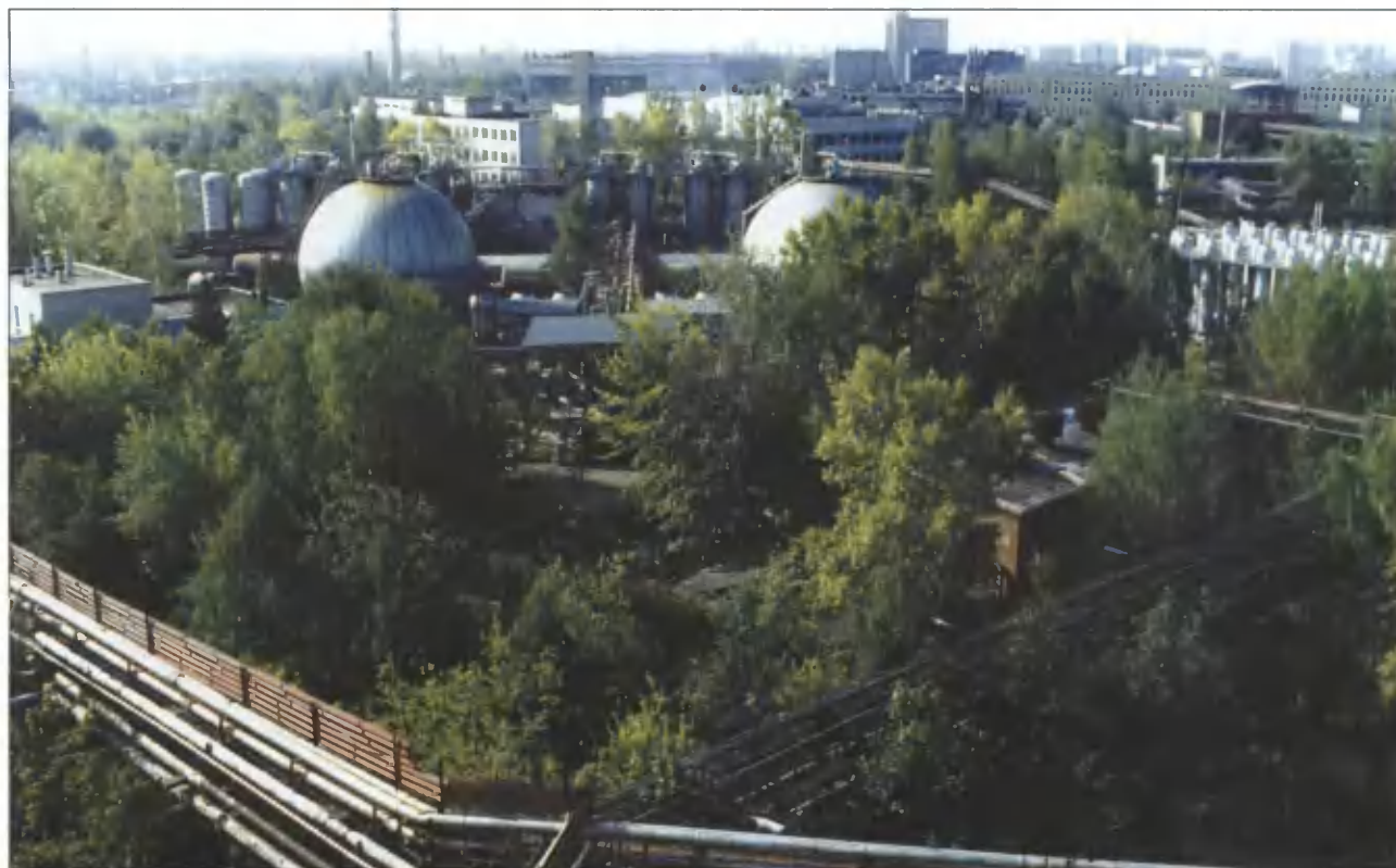
Инженерные сооружения на территории испытательного комплекса
