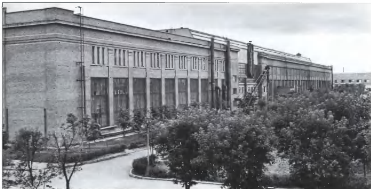
Здание главного производственного корпуса
