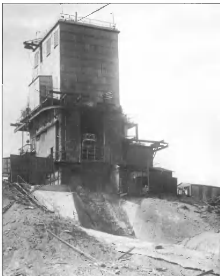
Стенд № 1 для огневых испытаний (1956 г.)
