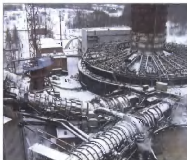
Газодинамический тракт и гидрогаситель
