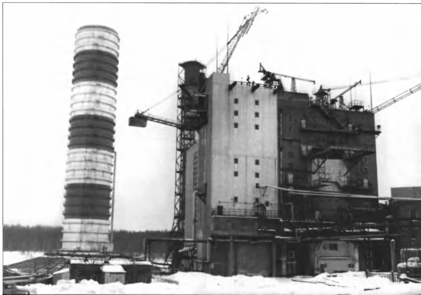
Стенд №2 для огневых испытаний (1982 г.)
