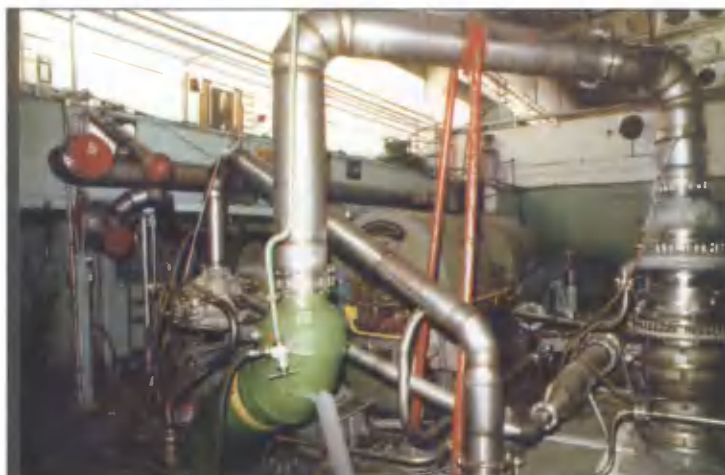
Стенд испытания бустерных насосов
