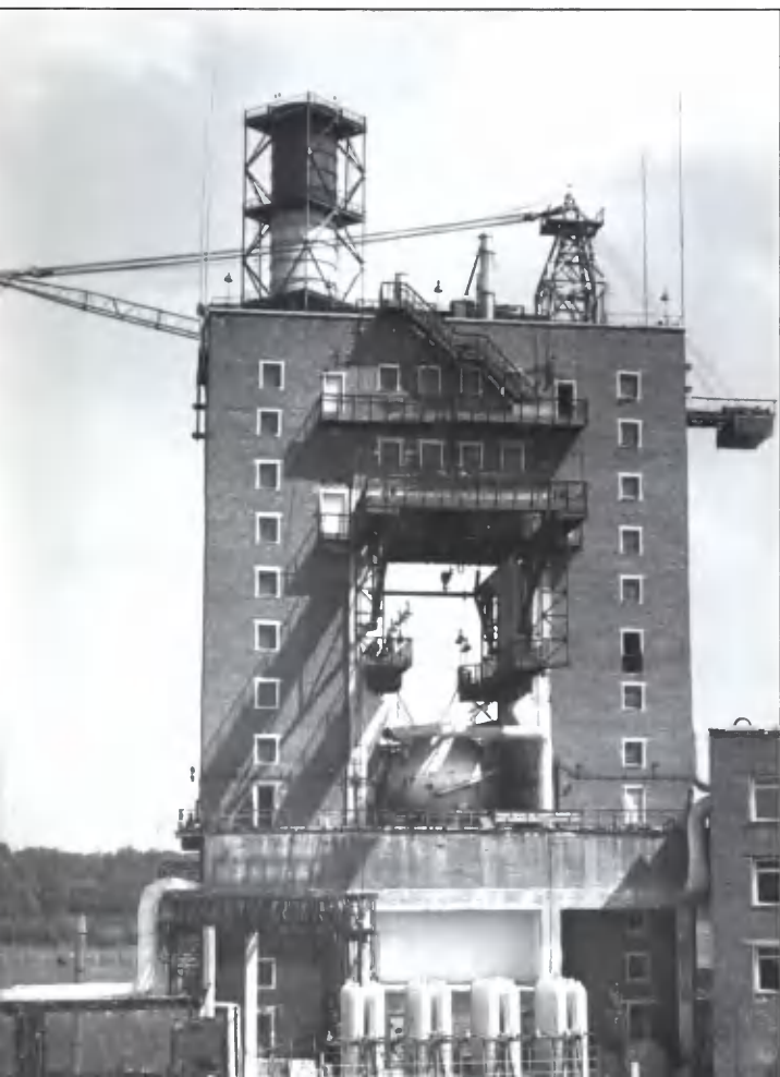
Стенд №2 для огневых испытаний (1967 г.)
