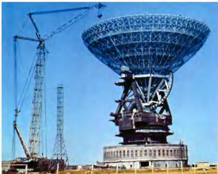
Рисунок 5.3 Монтаж антенной системы П2500 в г. Евпатория
